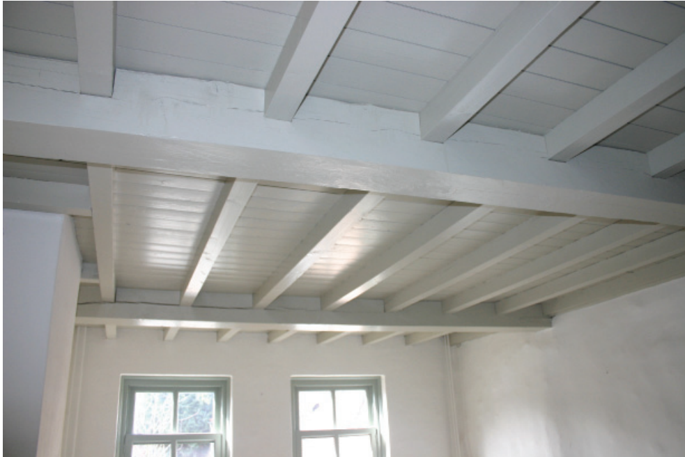
Afb. 9. De tijdens de restauratie aangebrachte samengestelde balklaag van de zoldervloer in het achterhuis.
